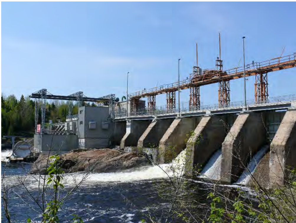
Figure 19 Barrage des Rapides-des-Cèdres. (Patri-Arch 2016, MRC d'Antoine-Labelle)
